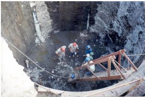
Figura 4. Poço Circular de 6,0m de diâmetro escavado com 11,0m de profundidade em solo mole.
