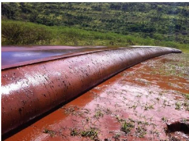
Figura 5. Tubo de Geotêxtil Preenchido com Rejeito de Mineração (Ober S.A., 2018).
