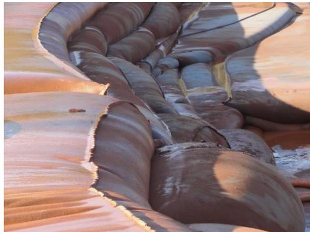
Figura 6. Tubos de Geotêxtil Preenchidos com Rejeito de Mineração e Empilhados (Ober S.A., 2018).
