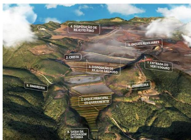
Figura 1. Diversos Setores de uma Barragem de Rejeitos (Samarco, 2018).
