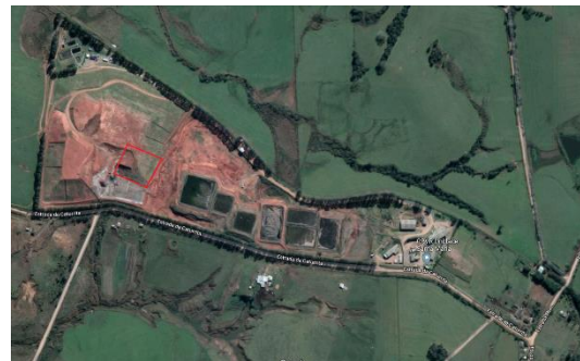
Figura 1. Localização da área D2/4 na CRVR Unidade Santa Maria (Adaptada: Google Earth, 2019)
