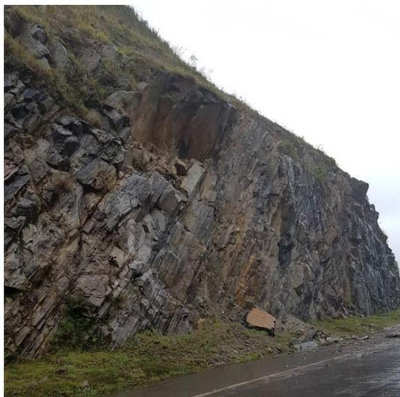
Figura 1: Blocos de rocha que se destacaram de um talude fraturado e intemperizado, nas imediações de uma via. Fonte: autoria própria.
