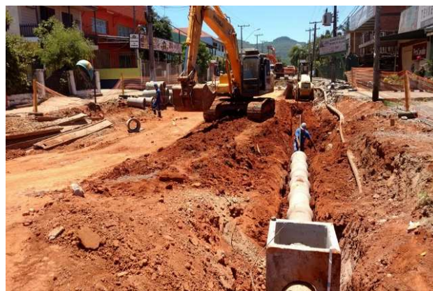
Figura 2. Escavação de Vala em Via Pública, em Novo Hamburgo (KUHN, 2019).
