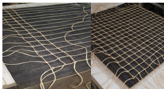
Figura 5 – Detalhe da montagem da geogrelha: (a) Gabarito e amarração, (b) Finalização.
