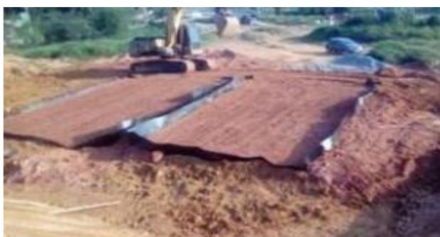
Figura 09 - Celulas com argila devidamente compactada
