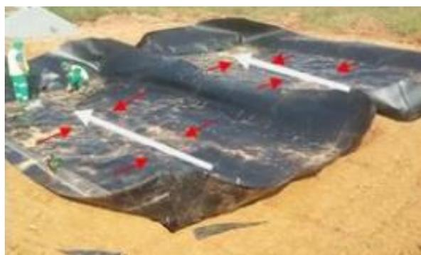
Figura 06 - Instalação da Geomembrana
