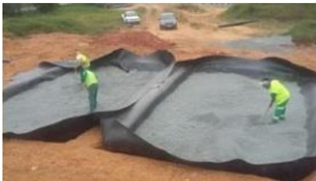
Figura 07 - Execução de camada drenante ( Brita)
