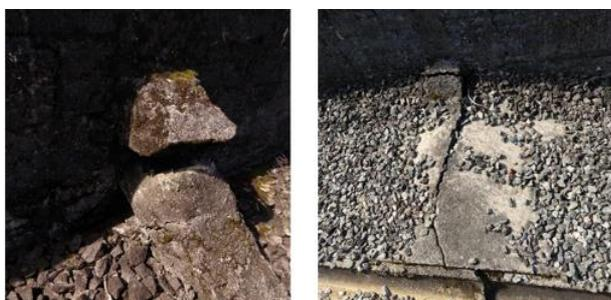
Figura 7. Elementos de reforço do muro, com patologias.
