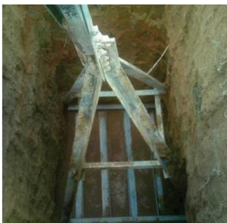
Figura 1: Fundação por Grelha Metálica Fonte: Braga (2013)
