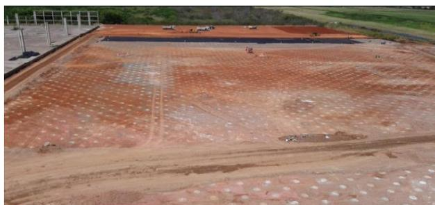
Figura 2. Malha de Colunas de DSM
