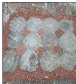
Figura 1. Superfície da coluna após arrasamento
