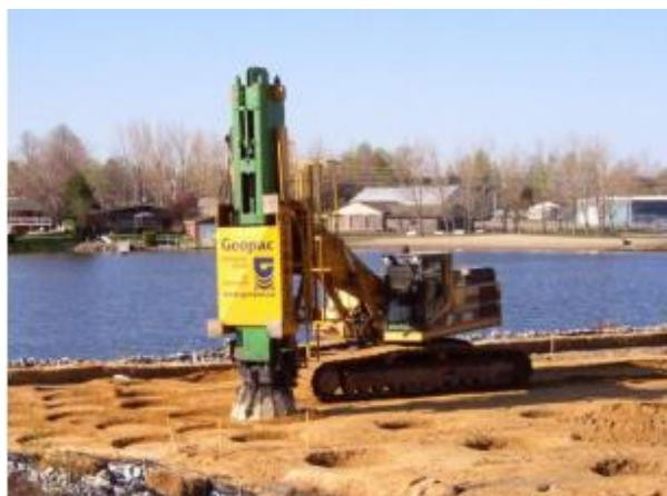
Figura 6. Equipamento sobre esteiras de compactação – RIC (Fonte: Lauzon *et al.*, 2011)
