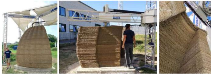
**Figura 13 - Impressão 3D de parede de uma unidade TECLA. Fonte: <https://www.3dwasp.com/en/3d-printed-house-tecla/> Acessado em 24/06/24.**
