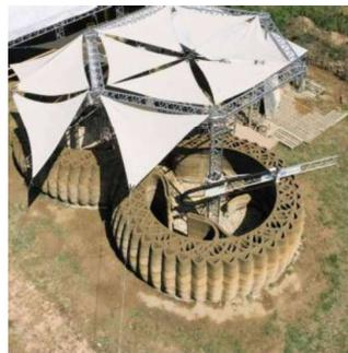
**Figura 12 - Vista aérea da Crane WASP e o processo de impressão 3D de uma unidade TECLA. Fonte: <https://www.3dwasp.com/en/3d-printed-house-tecla/> Acessado em 24/06/24.**
