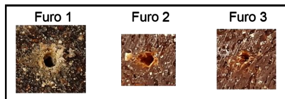
Figura 7: Ausência de fissuras no material. Fonte: Autores.
