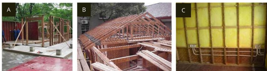
**Figura 6:** A) Instalação dos painéis modulares, B) Montagem da estrutura da cobertura e C) Isolamento Acústico e Térmico dos painéis. Fonte: Xiao *et al.*, 2010.
