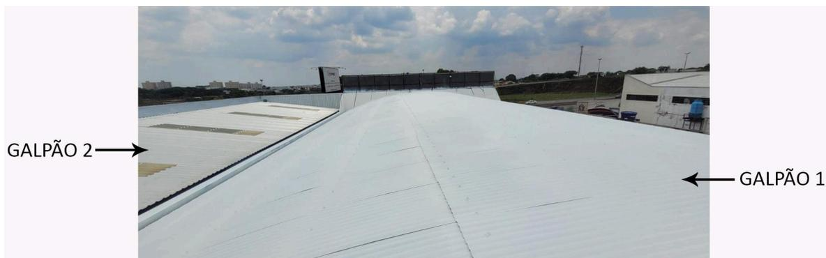
Figura 8: Telhado no dia da aplicação da tinta.(Telha galpão 2 e galpão 1). Fonte: autores.
