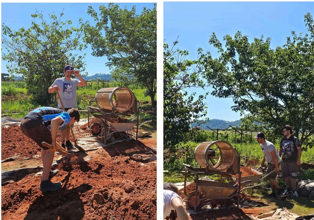
**Figura 2: Processo de peneiramento do solo, antes do dia de execução da parede. Fonte: autores.**
