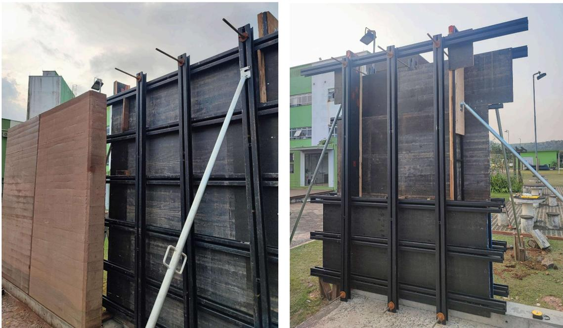
Figura 1: Sistema de formas adotadas para execução das paredes em Taipa de Pilão. Fonte: autores.
