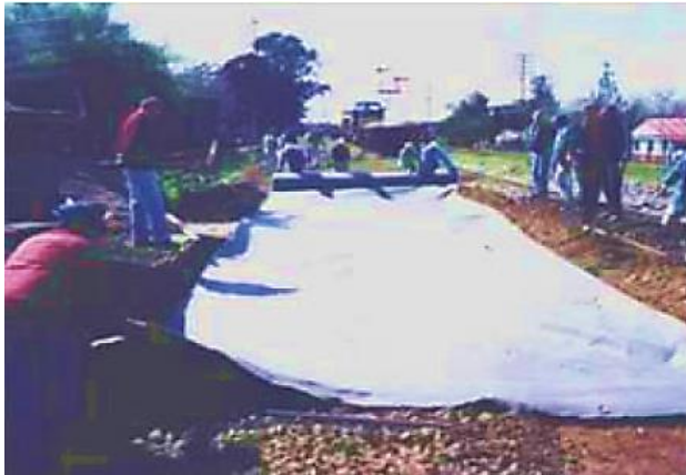
Figura 3. Instalação de manta geotêxtil como elemento de separação.
