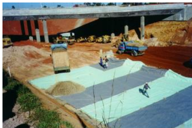
Figura 5. Instalação de diferentes tipos de geotêxtil em uma mesma camada de solo.
